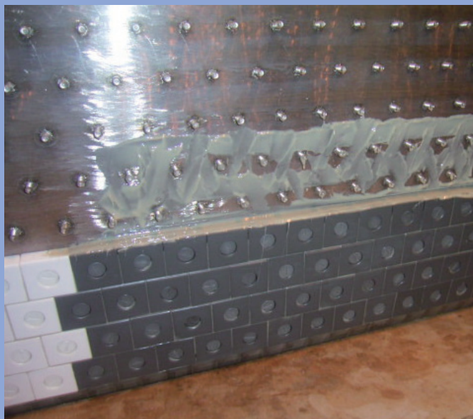
スタッド溶接
