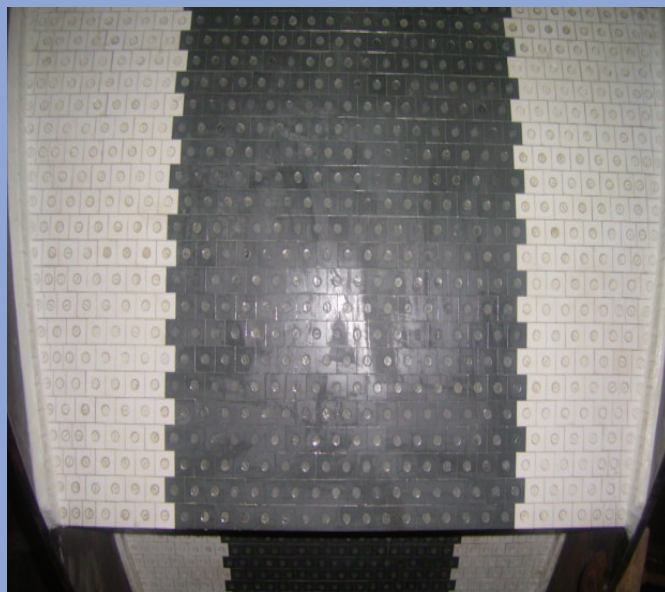
セラフィックス完成(送風機)
